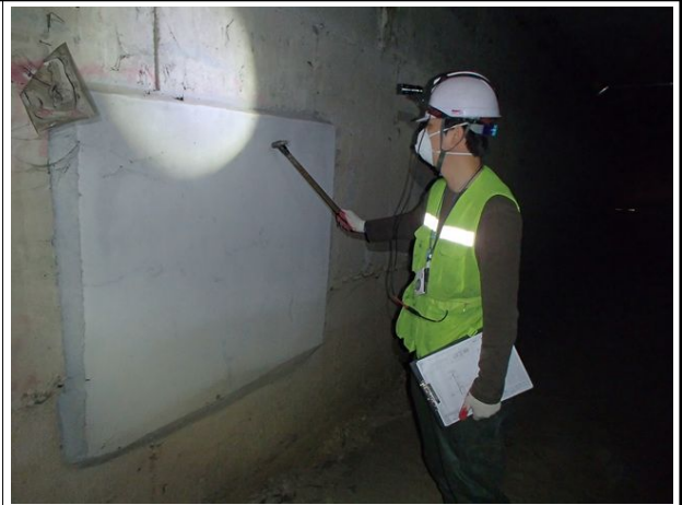
점검망치를 이용한 보수부 상태조사
