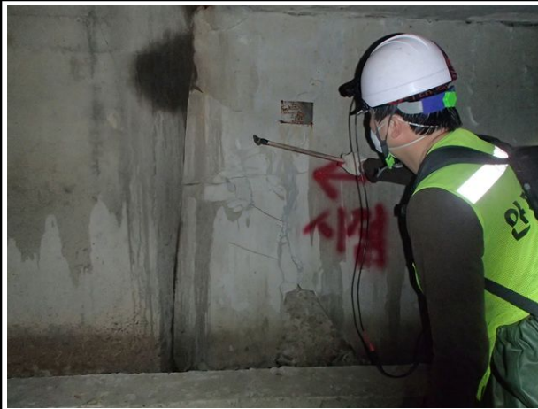
점검망치를 이용한 보수부 상태조사
