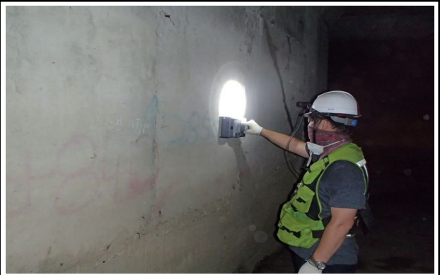
벽체부 철근탐사시험
